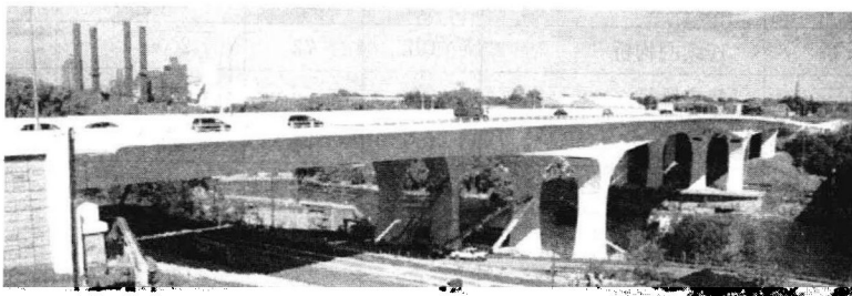
图 1.7 Saint Anthony Falls 桥
