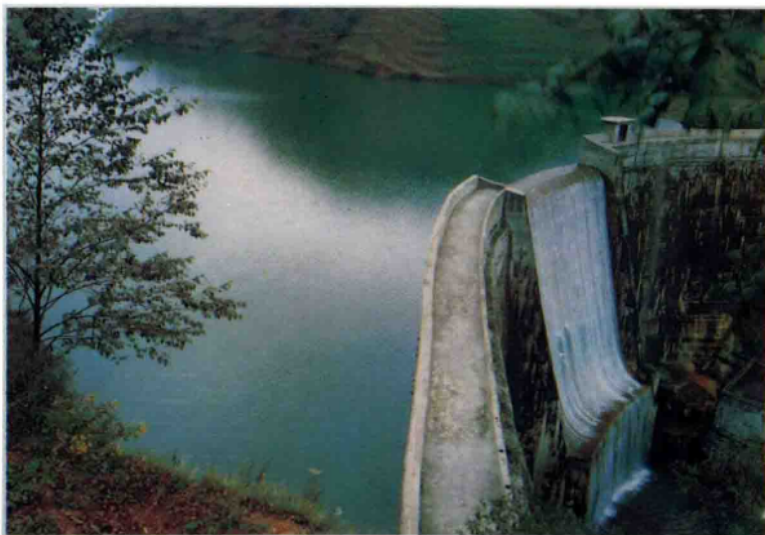
利民水库溢水景观。
