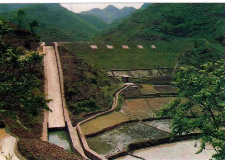
川黔公路线上的崔家沟水库全貌。
