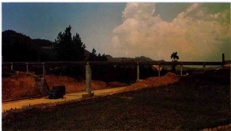
跨越贵毕公路的 狗跳岩电灌站渡槽。
