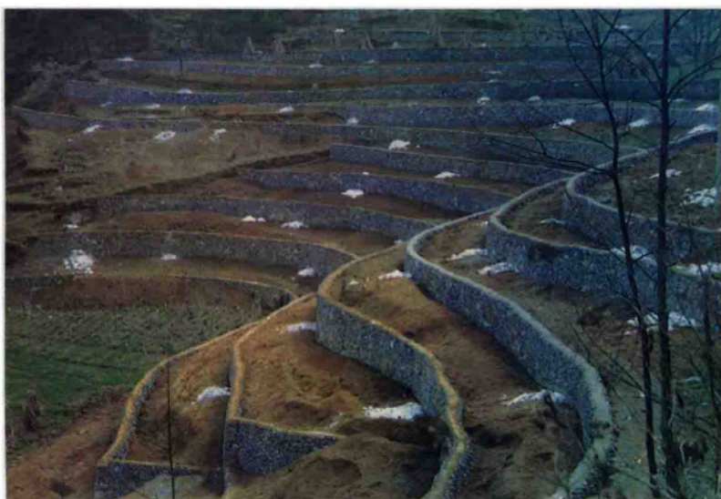
连片治理后的野角乡邓家湾坡改梯工程。
