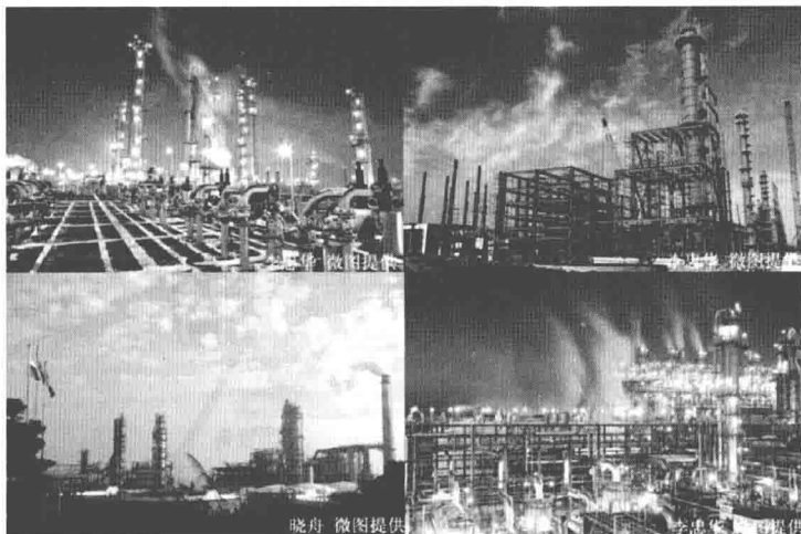
图 1-1 化工企业厂区
