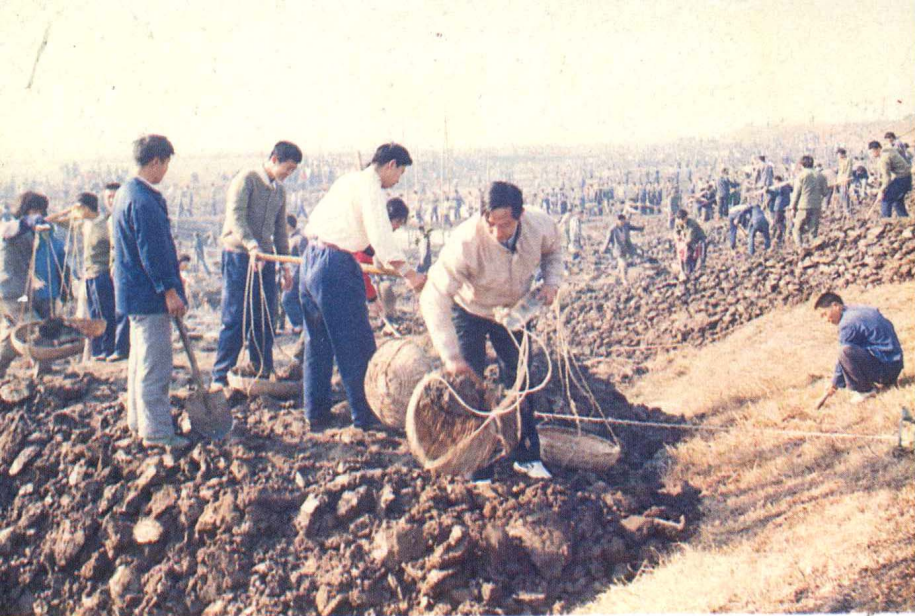
水利是农业的命脉。县长庞顺根和干部群众一起在殷巷水利工地上挑土方
