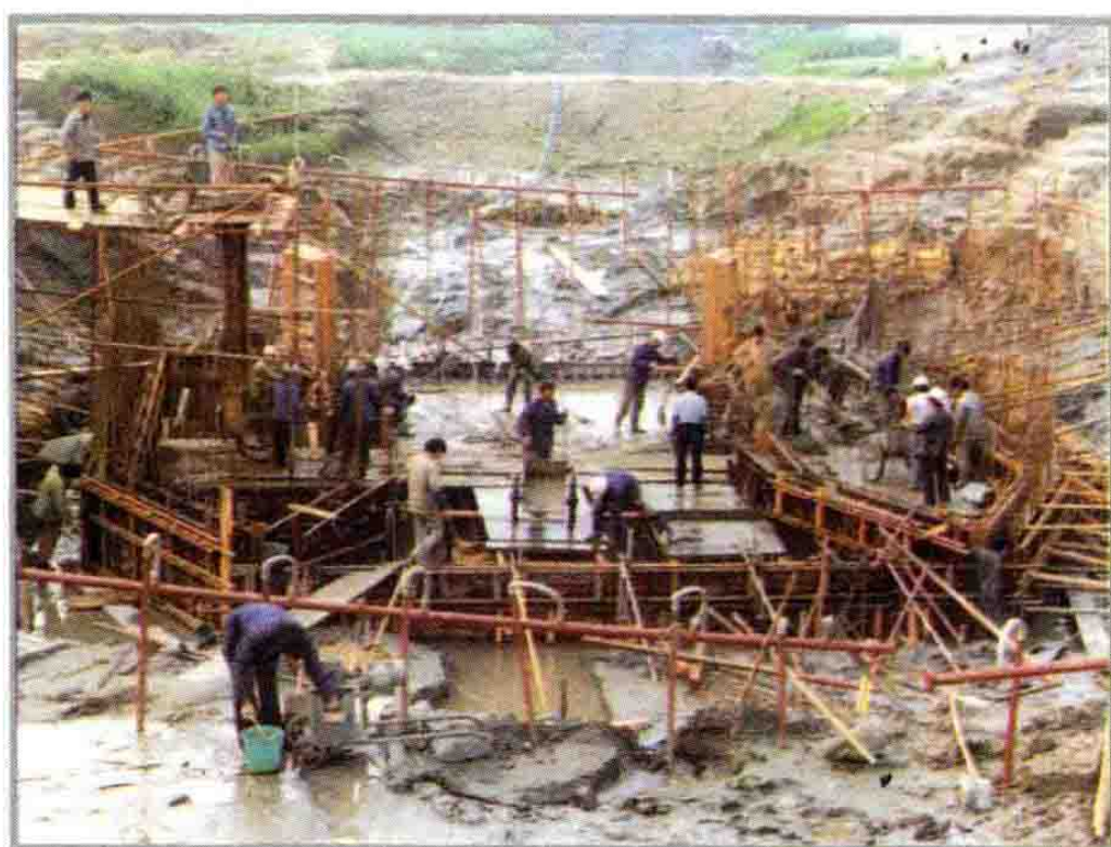
施工中的沙河套闸
