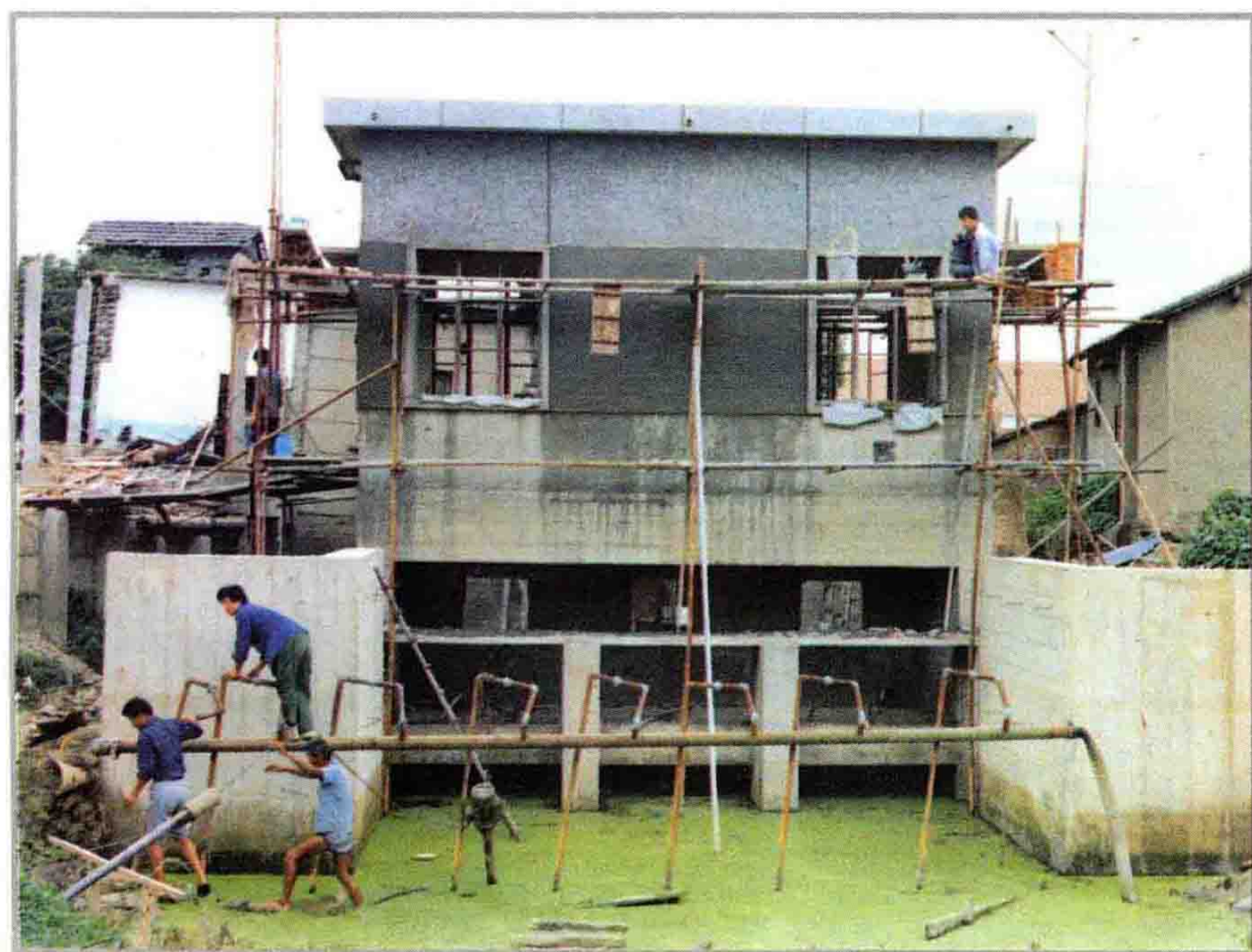
即将竣工的大场浜泵站
