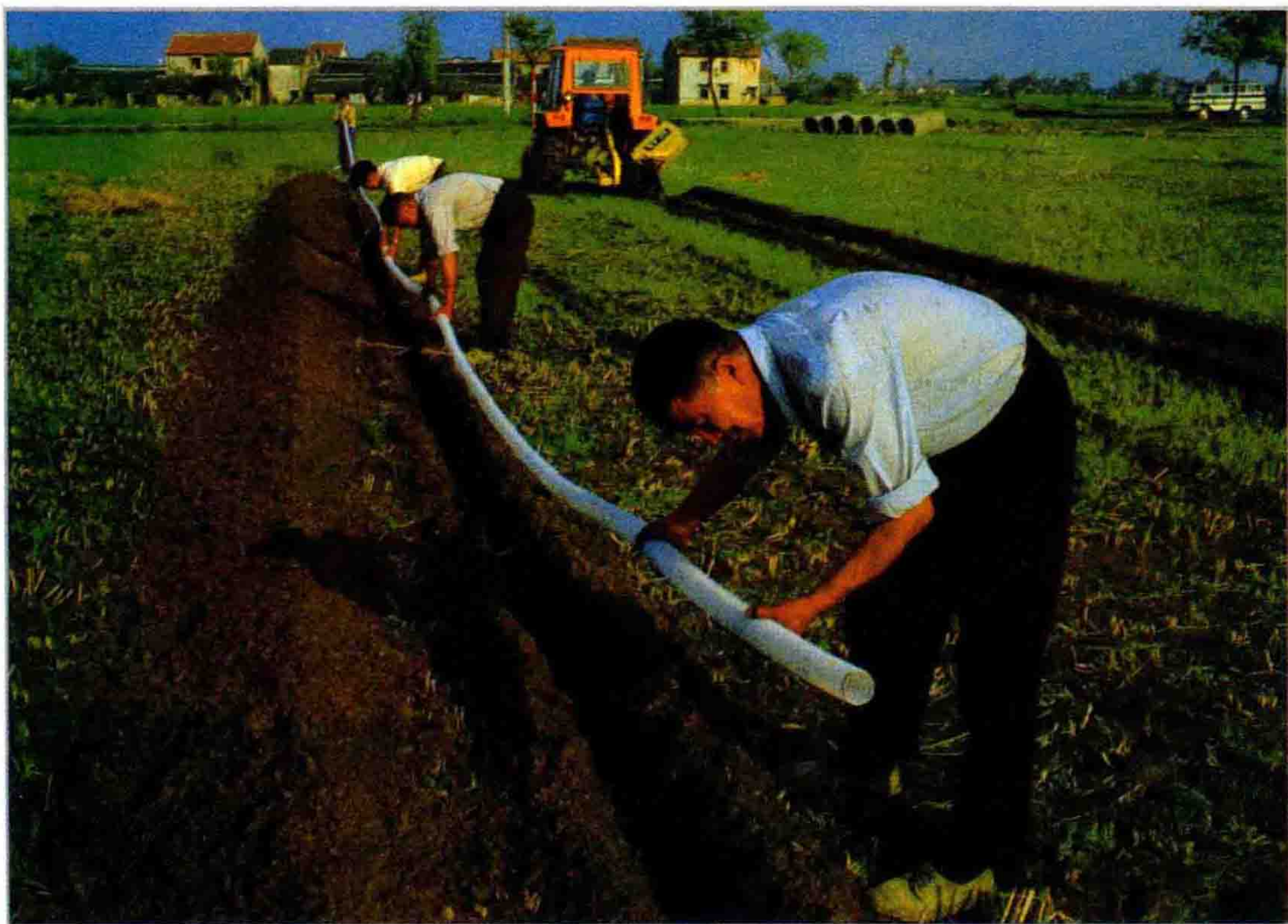
铺设多孔塑料暗管
