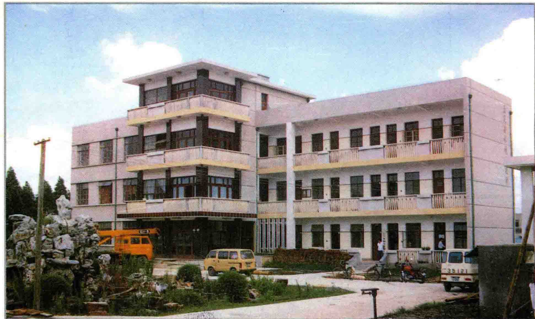
县水闸管理所
