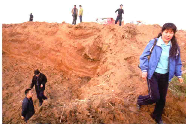
查看建设工地 在一些未经过考古勘探的建设工地上，挖掘和挖过的断面，容易观察到文物遗迹。工作人员在查看一处建设工地。
