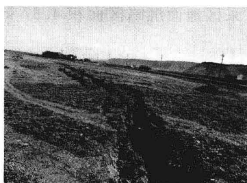
图 1-8 内蒙古白音华二矿边帮裂缝
