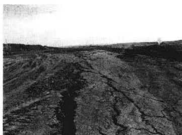
图 1-8 内蒙古白音华二矿边帮裂缝
