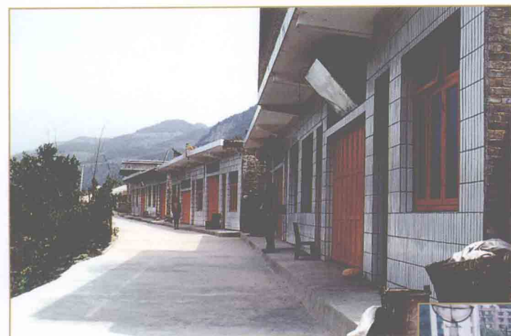
遵义县鸭溪镇 堰村安居工程
