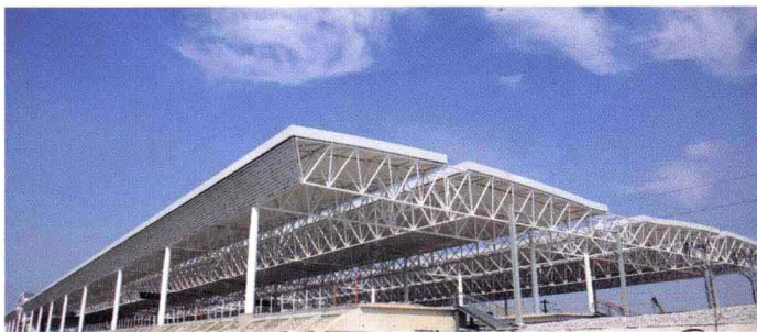
图 1—3 新建的沪杭高铁客站无站台柱雨棚
