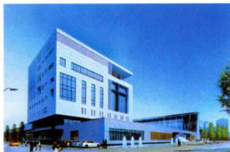
建设中的科技馆和图书馆
