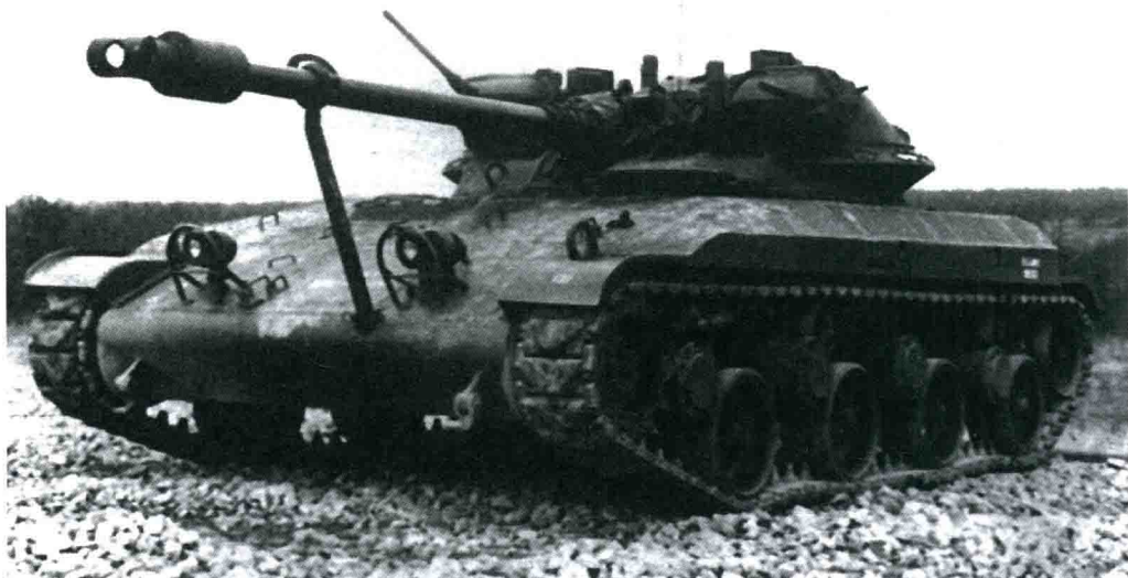
▲T92 轻型坦克样车〔缺乏对江河的浮渡能力也是造成 T92 下马的原因之一。1957 年，有情报显示，苏联正在研制一种具有浮渡能力的轻型坦克（即后来的 PT-76 水陆两用坦克），为此，美国陆军也要求 T92 具备浮渡能力，但是按原来的设计，这个指标很难达到〕
