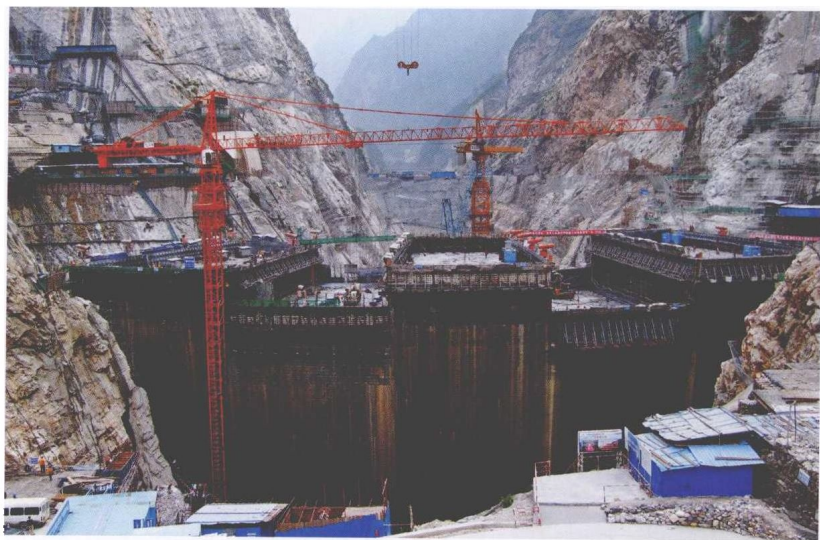
施工中的雅砻江锦屏一级水电站工程
