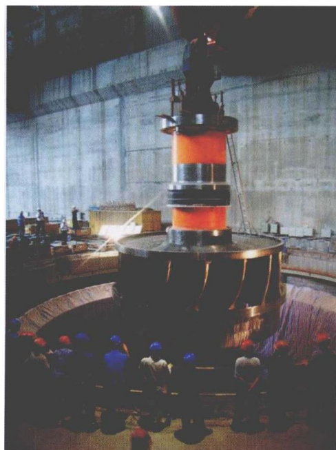
2010年6月，云南金安桥水电站首台机组转轮吊装就位
