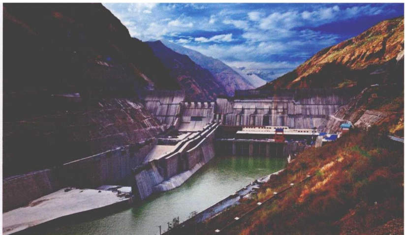
建设中的云南金安桥水电站
