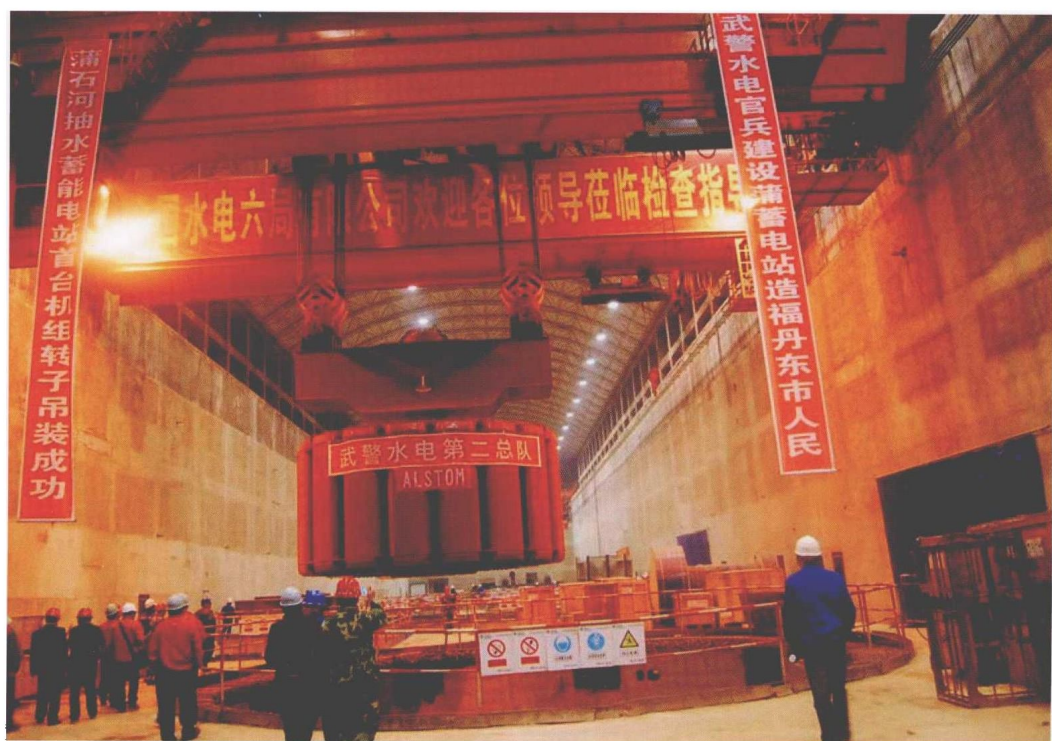
2010年10月1日，辽宁蒲石河抽水蓄能电站首台机组转子顺利吊装成功
