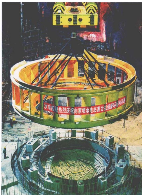
2010年3月23日，金沙江向家坝水电站1号机组座环整体吊装就位
