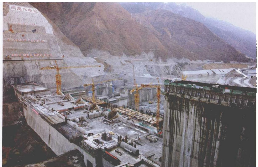
金沙江阿海水电站施工现场
