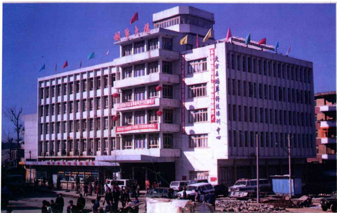
大方县烟草公司办公大楼。
