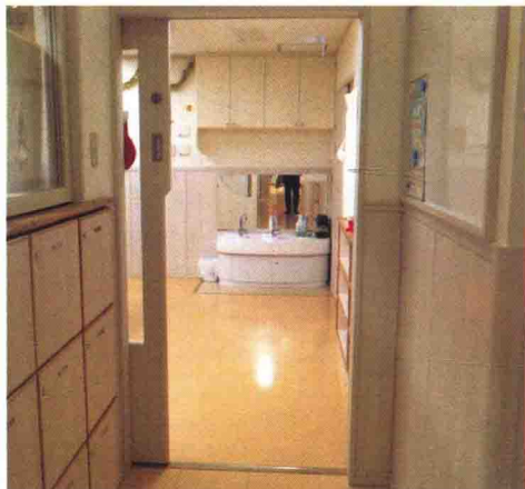
图 0-19 将门锁安装在比较高的位置，以免幼儿园里的小朋友擅自打开门出去后受伤。而且在小朋友手可以够到的高度范围内留出了一条缝隙，这样就不用担心夹到手了
