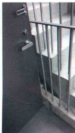
图 0-17 (左) 门被楼梯扶手下面的混凝土挡住了而无法完全打开，所以把混凝土削掉了一部分(提供者：西条瞳小姐)。(右) “本公司的市场占有率”比“某大公司的市场占有率”多还是少(详见 P.206)
