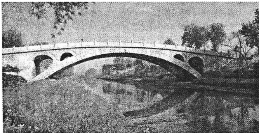
图 1.5 河北赵县洹河上的赵州桥（安济桥）
