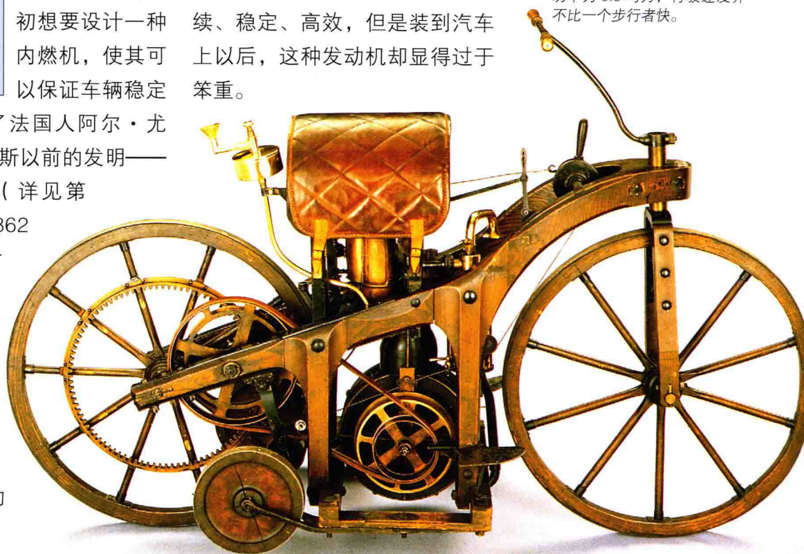
世界上第一辆汽车（更确切地说为摩托车）：1885年由哥特利布·戴姆勒制造的马式汽车，功率为0.5马力，行驶速度并不比一个步行者快。
