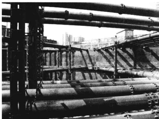
图 2.2 换乘节点坑深-26.0m
