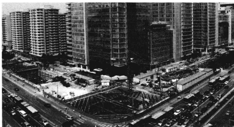
图 2.1 白石桥南站工程全貌
