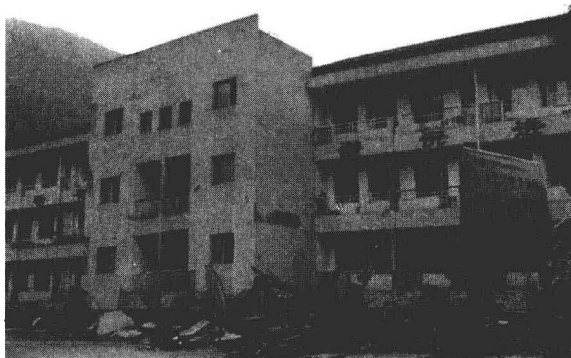
a)底部薄弱层(两层)倒塌
