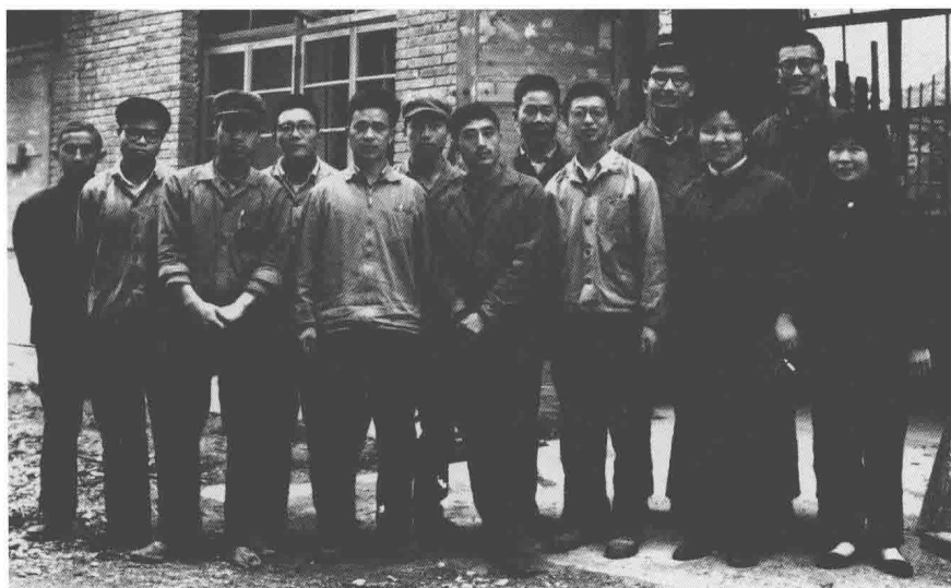
照片5 1975年安装600×6铰链式六面顶压力机的合影
