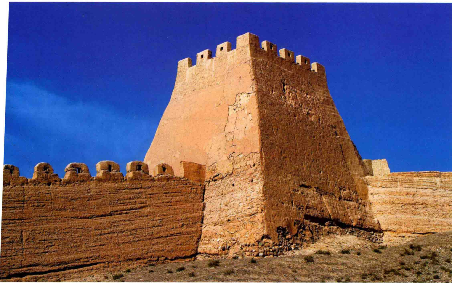
图 0-0-5 嘉峪关附近一段夯土城墙
