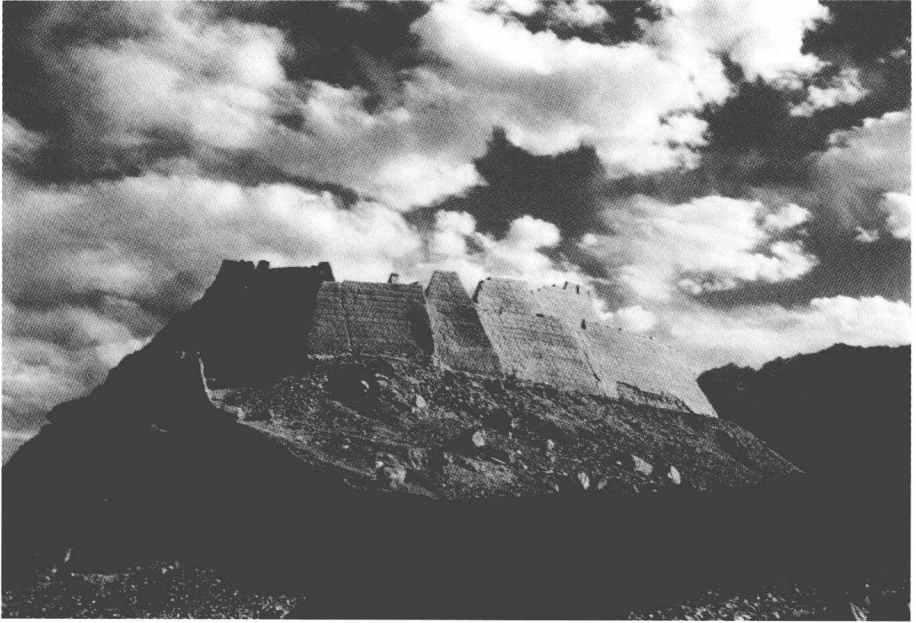
5.塔什库尔干唐石头城遗迹，高处为清蒲犁厅，低处为唐城，玄奘曾在此停留
