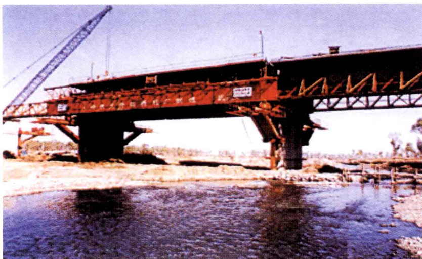
图 1.2 移动模架原位现浇法施工
