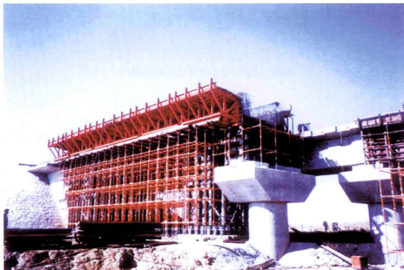
图 1.3 膺架法施工中的简支箱梁
