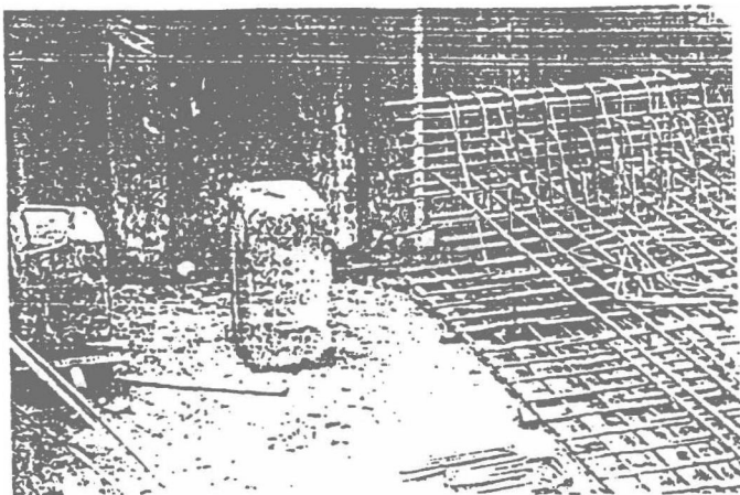
图 1.3 隧道底板的配筋
