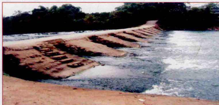
鹤山镇五龙村翻水桥
