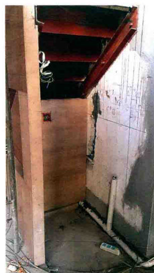
利用楼梯下空间，设置洗衣机位置
