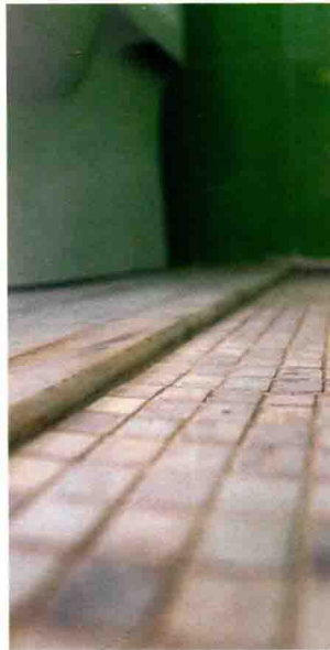
淋浴区地面高差非常小
