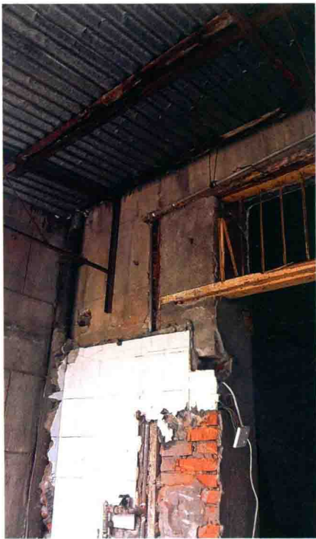
拆除不合理装饰结构
