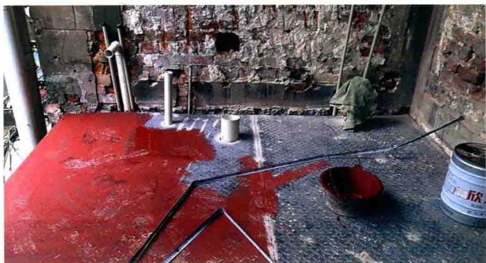
利用钢结构对两面墙体做支撑，将地梁移除
