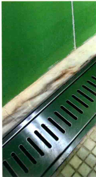
安装较大的排水沟
