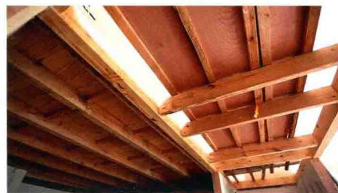
使用自重小的木结构，对老建筑的负荷小，从而减小了老建筑的承载压力
