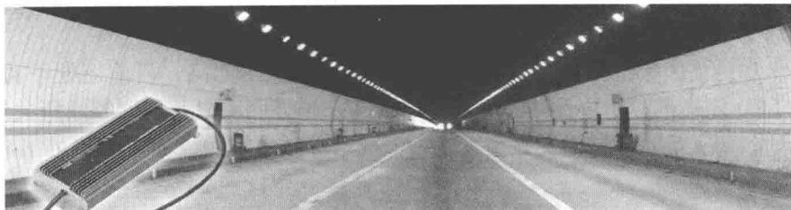
(b) LED隧道照明
