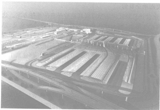
图3 港澳珠大桥香港边检站鸟瞰图 ④
