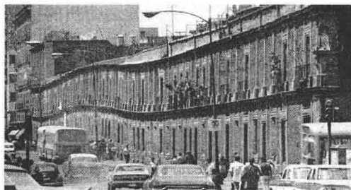
图 0-10 墨西哥城一幢建筑的不均匀沉降
