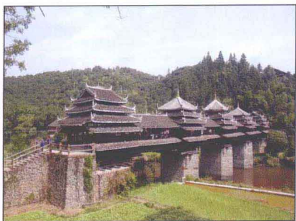
程阳风雨桥 是建筑的集大成者，集桥、廊、亭三者于一身，在中外建筑史上独具风韵。
