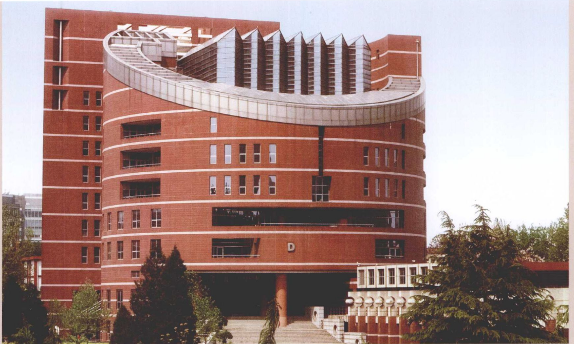
2002年建成的凝聚态物理综合楼（D楼）
