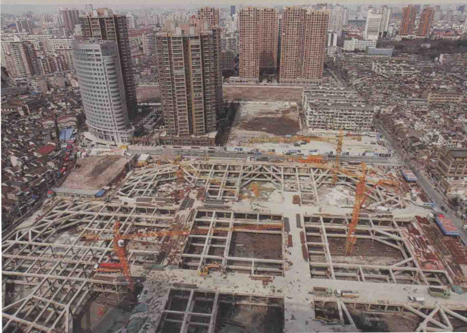
图1-1 建设中的工地
