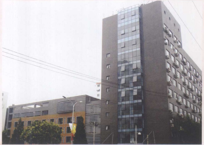
▲ 建设中的教师大厦新楼外景（原北京实验大学校址，现为学院中轴路校区）
