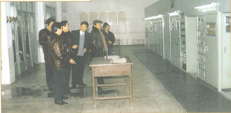
贵州省广播电视厅副厅长罗德成检查黔南州都匀中波台机房的播出情况
