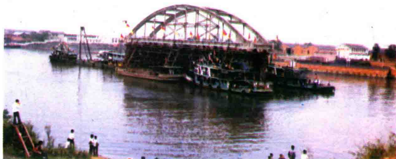
扬州大桥系杆拱在搬迁中
