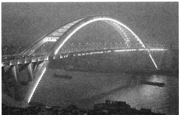
图 1.4 上海卢浦大桥
