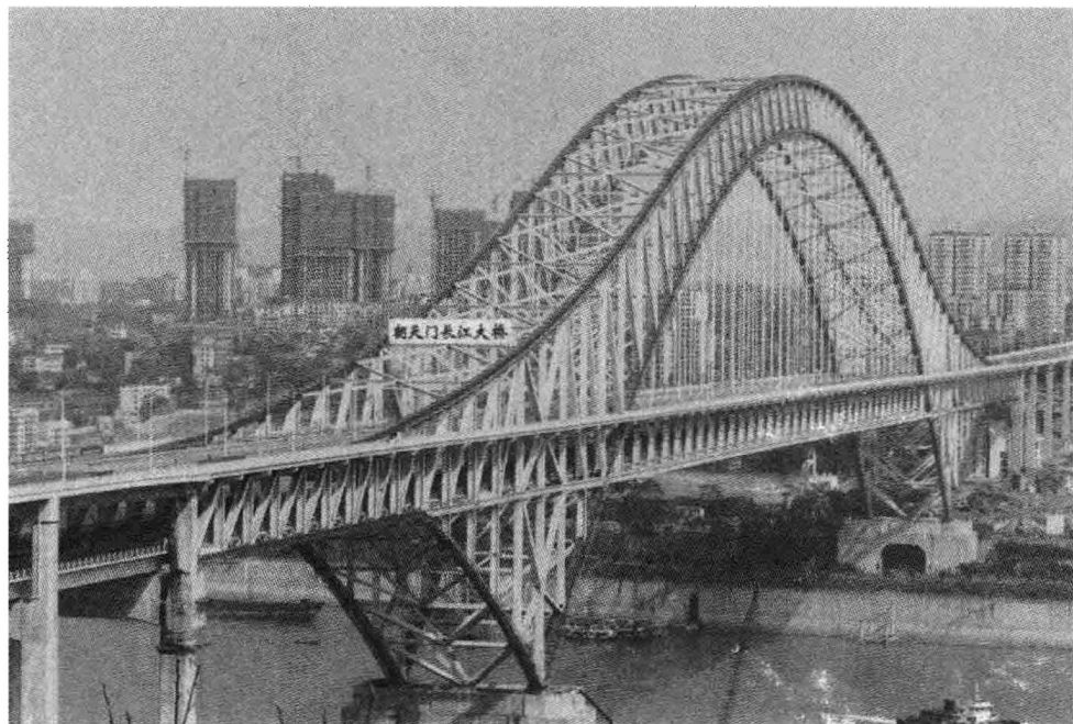
图 1.6 朝天门长江大桥
