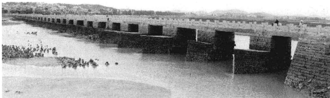
图1.1 福建泉州万安桥(洛阳桥)
