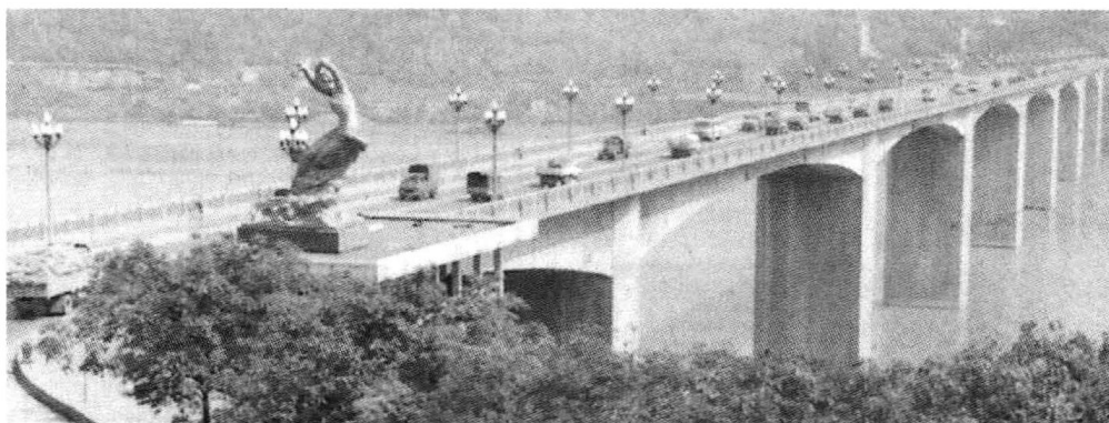
图 1.7 重庆石板坡长江大桥
