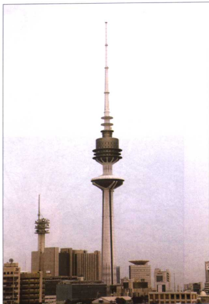
新建的电讯塔——解放塔
