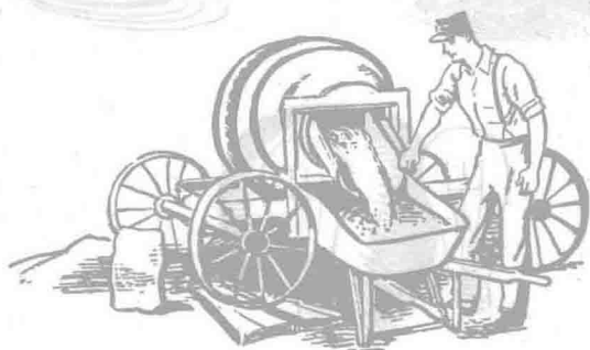
一批新搅拌好的混凝土正在倒入小车。这是非均匀混合物(不是整个都均质的混合物)的一个很好例子
