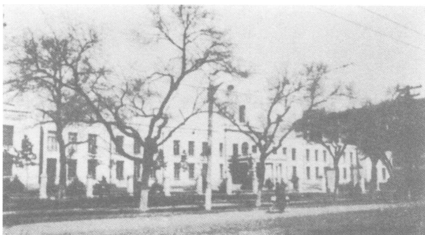
16. 哈尔滨外语专门学校白楼旧址。
