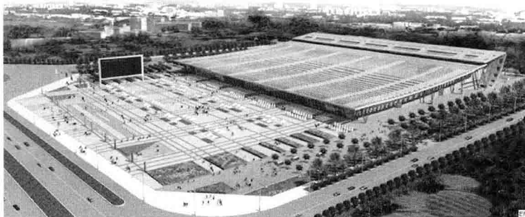
安徽国际会展中心——合肥展馆
