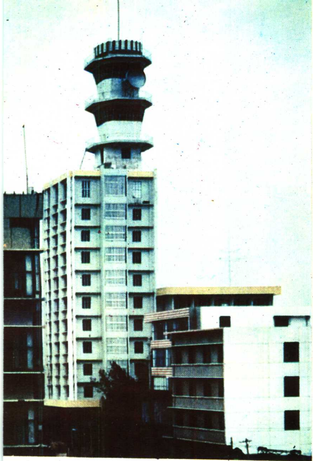
三门峡调度微波楼是黄河中下游的水利电力通讯枢纽中心。
