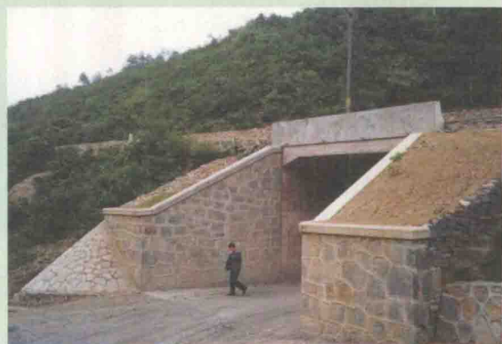
竣工后的“平改立”工程
