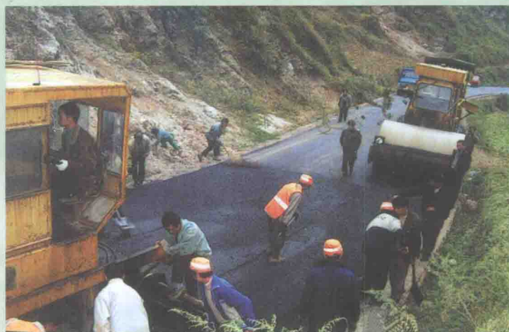
建设中的县乡公路
