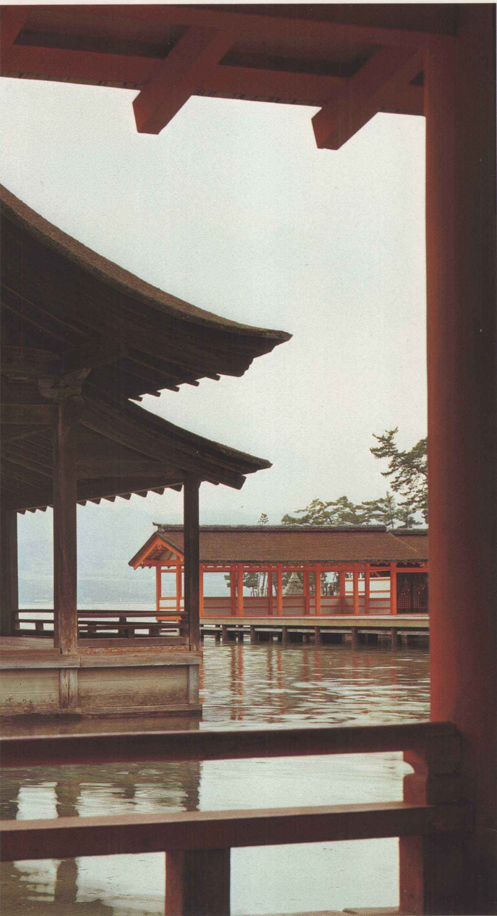
5 厳島神社能舞台——海に浮かぶ舞台。 橋掛りは吹き抜けて遠くの海が見える。現在、 能を上演する時にはこれを板で閉ざし、裏側に 切戸への臨時の通路を作るが、本来は切戸がな く、諸役すべて橋掛りより登場していたのであ ろう。地謡座の上の庇(ひさし)は、これがあと で付け足された痕跡を示すものとも見られ、舞 台の古形をうかがい知ることができる。笛柱が 独立して立っているのは、一般の舞台と異な る。室町時代末期、毛利元就の時代の創建と伝 える。／広島県・厳島神社
