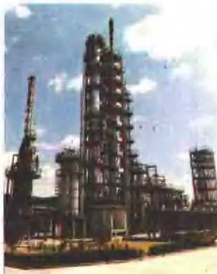
催化裂化裝置
