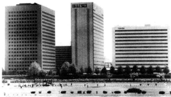
疑惑の発端となった「かわさきテクノピア地区」の リクルートビル
