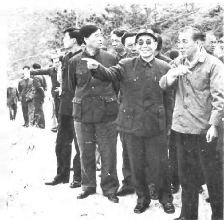
国务委员康世恩同志（前右二）在视察蛇口赤湾港
