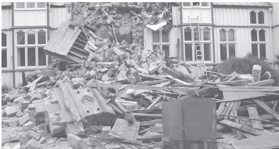
图9 地质移动引发房屋倒塌
