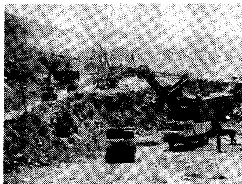
图 1-1-1 WD400 型单斗挖掘机进行基础开挖的情况
