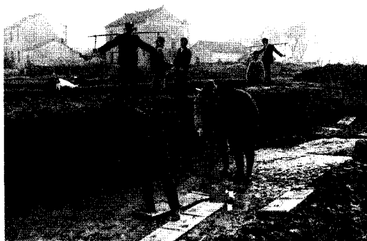
古稻田挖掘现场
