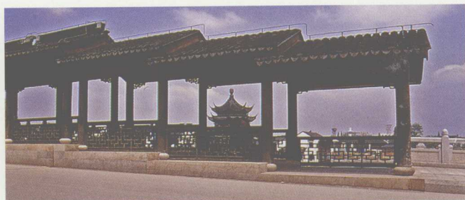
气通闾阖（透廊侧看白居易纪念馆）
