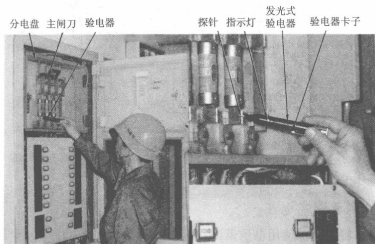
图 1.3 氖管发光式验电器验电
